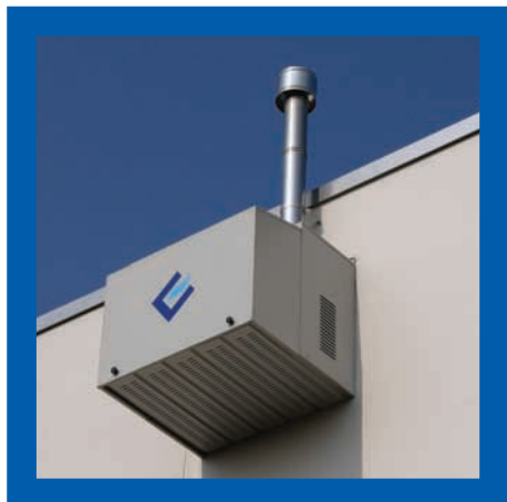
Внешний блок с дымоходом
