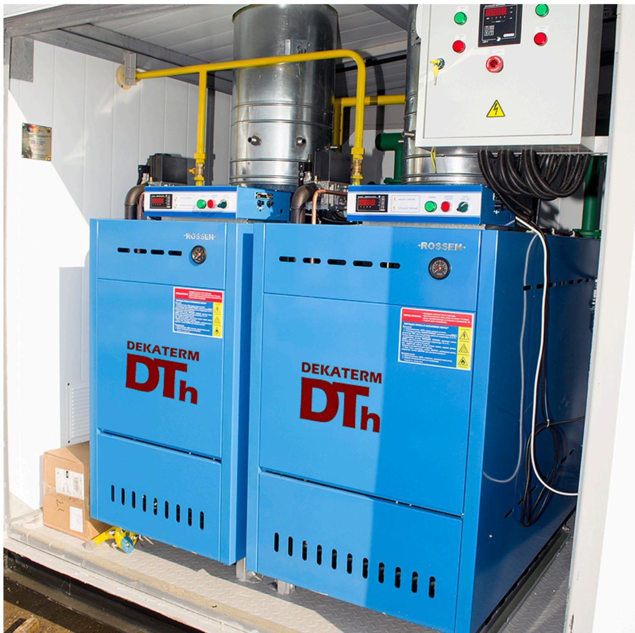
Внимание: Нельзя заливать в систему отопления незамерзающую жидкость, это приведет к пристенному кипению в трубах котла.
